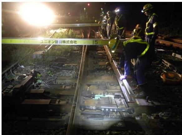
駅構内には列車を他の線路に移動させるために分岐器が多数あります。分岐器のレールは列車が通過すると少しづつ削れてきます。そのため、定期的にレール交換をする必要があります。写真は分岐器の一部のレールを交換しているところです。定期的に交換することにより、列車が通過した時に脱線することなく列車を安全に走らせることができます。
