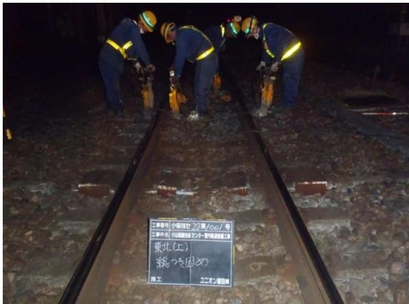
列車が通過した際、線路が上下に動き乗り心地が悪くなるので、ジャッキで線路を持ち上げます。持ち上げた際に出来るマクラギと碎石の隙間にタイタンバーで振動を与えて碎石を詰め込んでいきます。作業後は、線路が締まっているので、列車が通過しても上下に揺れことがなくなります。
