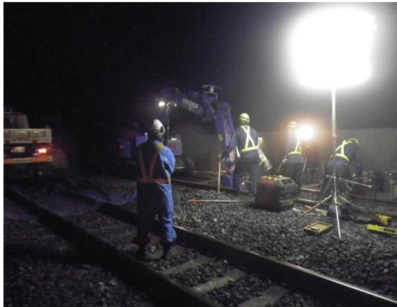
列車が毎日走っていると碎石が小粒になつたり、雨水が溜まって噴泥したりして車の乗り心地が悪くなる原因となつてきます。そうした箇所を直すために重機械(BH)を使用して碎石の交換を行います。
