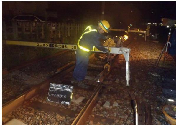
列車はレールの上を走ります。レールの損傷や摩耗など列車が通過した年数によってはそのままにしておくと脱線事故に繋がりかねないので、年間を通じてレール交換を行っています。一晩でレール交換する長さは最長で400mの交換を深夜、列車が走らない約2時間で行っています。
