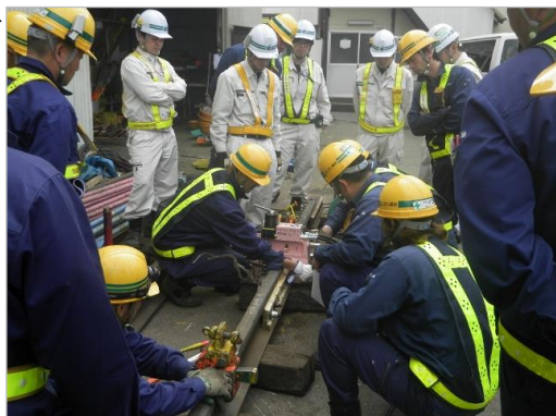
ハックボルト取付け指導する 糸瀬副所長
