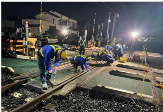
8月に初めて臨んだ 連接軌道締結装置交換作業
